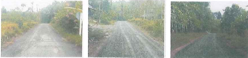
๑๗. โครงการซ่อมแซมถนนรหัทสทางหลวงท้องถิ่น นศ.ถ. ๑๒๕-๐๙ สายบ้านไสยาร่วง-บ้านไสยัว หมู่ที่ ๑
