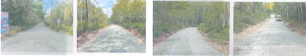
๙. โครงการซ่อมแซมถนน รหัสทางหลวงท้องถิ่น นศ.ถ. ๑๒๕-๕๑ สายบ้านห้วยแก้วบน-บ้านควนโดน หมู่ที่ ๖
