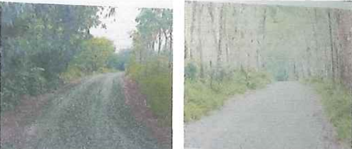
๑๒. โครงการซ่อมแซมถนนทางหลวงท้องถิ่น สายบ้านห้วยไก่อ-หนานเสี้ยว หมู่ที่ ๔
