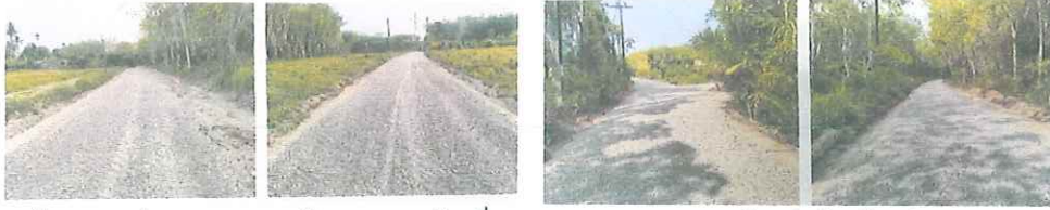
๘. โครงการซ่อมแซมถนน รหัสทางหลวงท้องถิ่น นศ.ถ. ๑๒๕-๓๗ สายบ้านทุ่งค้อ-บ้านทุ่งคอกควาย หมู่ที่ ๕
