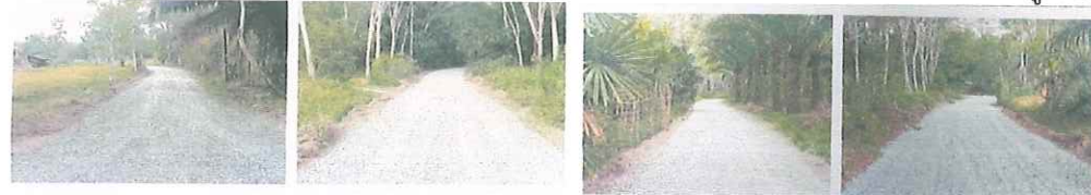
๑๘. โครงการซ่อมแซมถนนรหัทสทางหลวงท้องถิ่น นศ.ถ. ๑๒๕-๑๐ สายข้างโรงเรียนมัธยมศึกษาจุฬารักษ์ หมู่ที่ ๑
