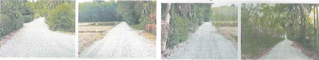
๑๑. โครงการซ่อมแซมถนนทางหลวงท้องถิ่น สายบ้านสวนพลู หมู่ที่ ๕
